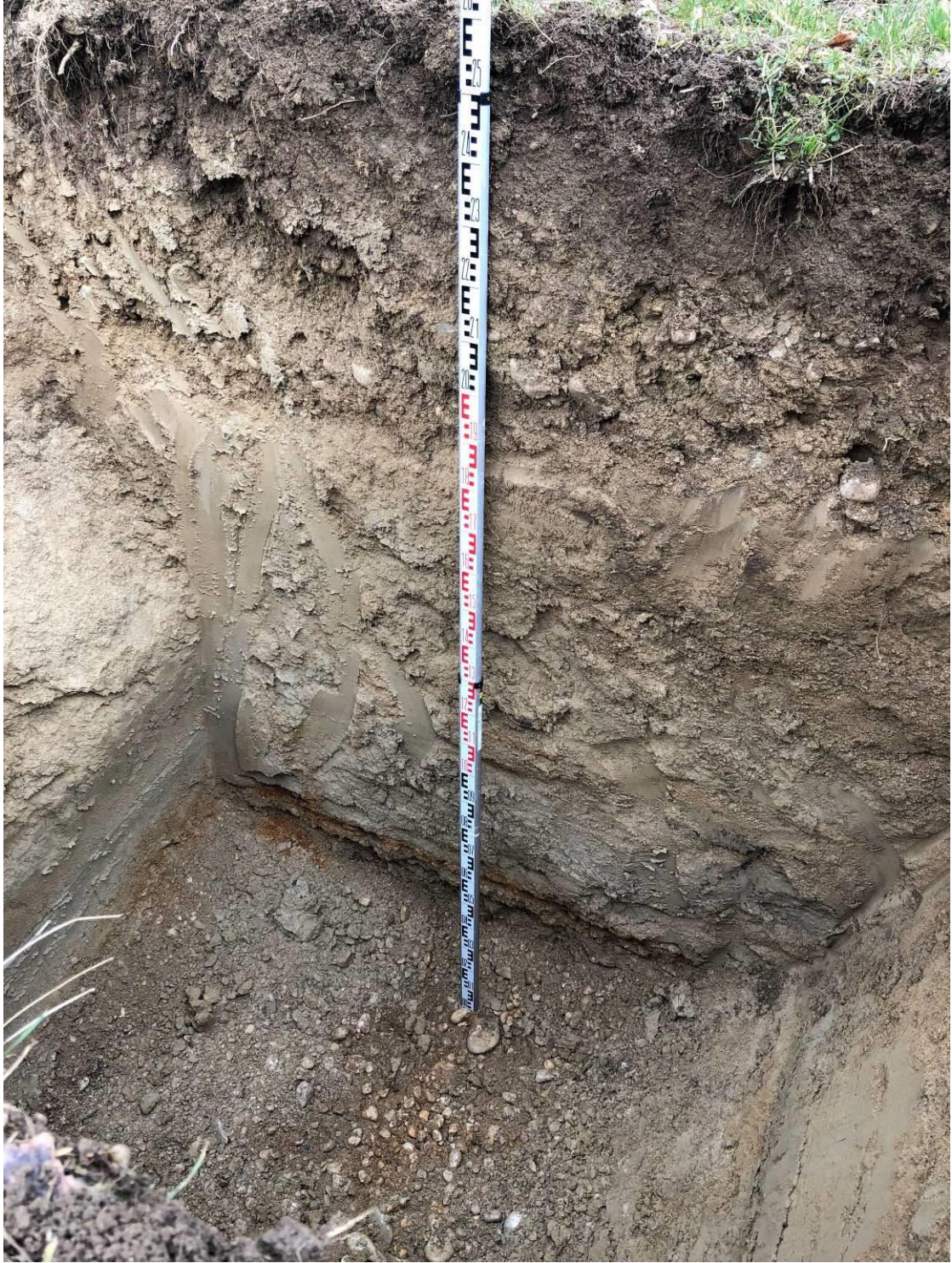
Fouille CL-03 à 2.6 m de profondeur par rapport au terrain naturel.
